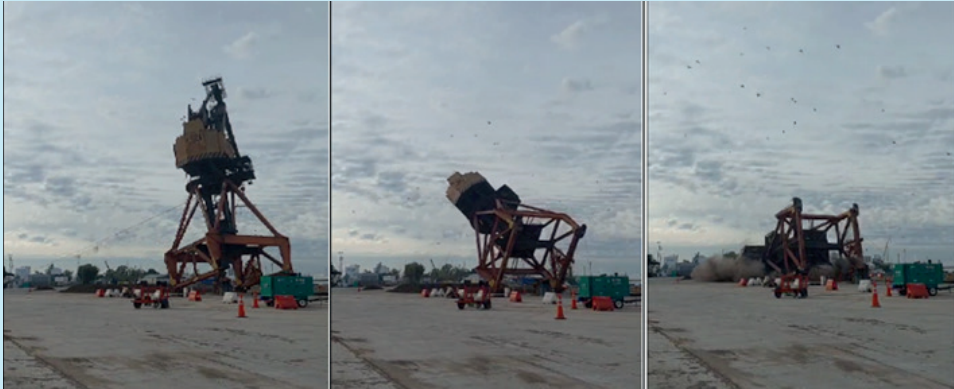
Vuelco Controlado de Grúa Cerretti en Sitio 5 Puerto Galván para eliminación de riesgo.
