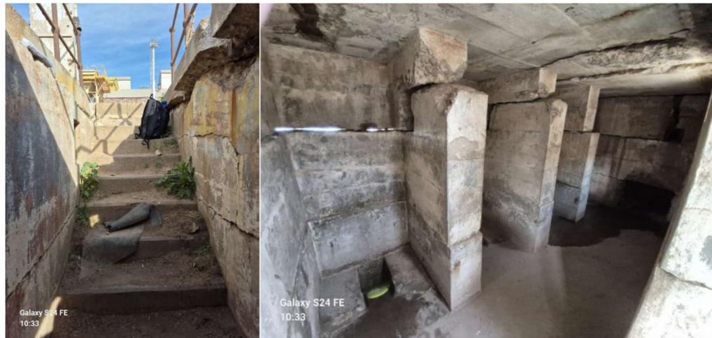
Figura 3 - Vista sanitarios y escalera de acceso existentes bajo piso de muelle
