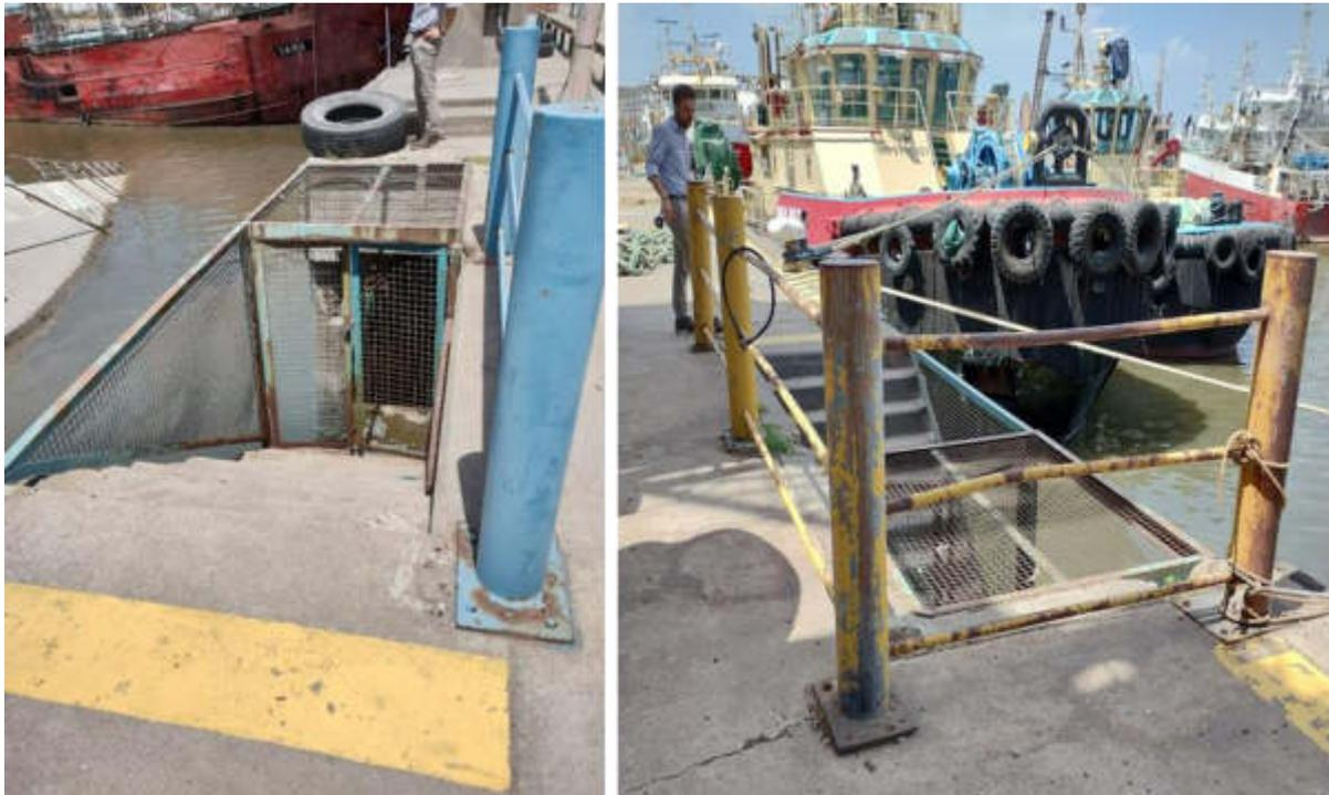
En cuanto a las barandas de protección, se deberán reemplazar por unas nuevas, conformadas por caño redondo de hierro negro  $\varnothing$  ext. 101,6mm (4”), espesor 3,20mm, a cimentación mediante soldadura a placa de anclaje y pernos de anclaje a hormigón existente. Las mismas tendrán una altura de 1m.
