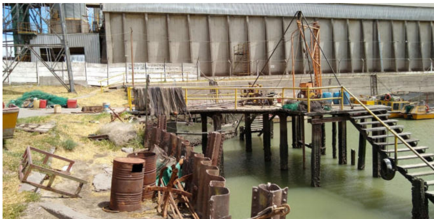
Foto 1. Equipo de perforación instalado en viaducto de acceso a plataforma de atraque.
