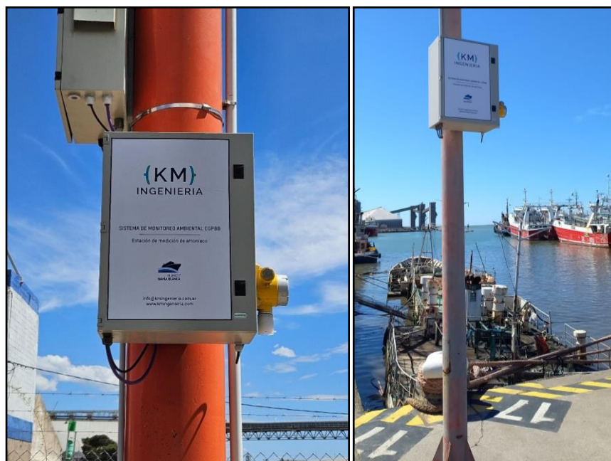
Fotografía 3.2 Sensor de Amoniaco – Sitio 19 – Puerto Ingeniero White
